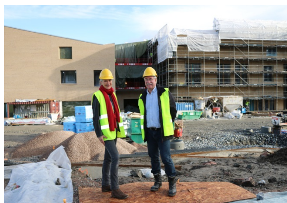
Byggingen av Nye Hegg skole er i rute. Skolen tas i bruk for fullt høsten 2015.
