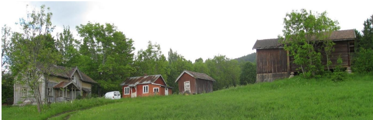
Figur 1: Ved oppussing og rehabilitering av eldre bebyggelse må man søke om ny utslippstillatelse. Tilsynskontoret behandler slike søknader fortløpende.
