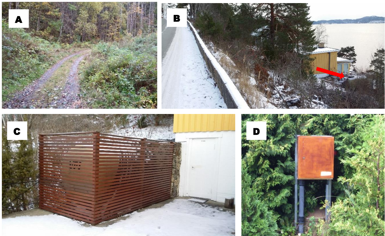
Figur 8: A) Dersom adkomstveien ikke er tilgjengelig for stor lastebil, må det påregnes ekstrakostnader ved slamtømming. Det beste vil i slike tilfeller være å ha avløpsløsning som ikke trenger tømming, f.eks. forbrenningstolett / bido uten vannspyling og gråvannsanlegg som ikke trenger tømming. B) Her er kloakktanken plassert i svært bratt terreng, og tømmebilen må stå på svært trafikkert vei for å få tømt. Tanken ligger 15 meter lavere enn veien, derfor har tømmebilen vansker med å få sugd / løftet slammet så høyt. C) Kloakktank er innebygget og plassert på terrassen. I tillegg til at den er vanskelig tilgjengelig for tømming skaper den sjenerende lukt på uteplassen, og mangler frostsikring. D) Denne tanken er også vanskelig tilgjengelig for tømming.
