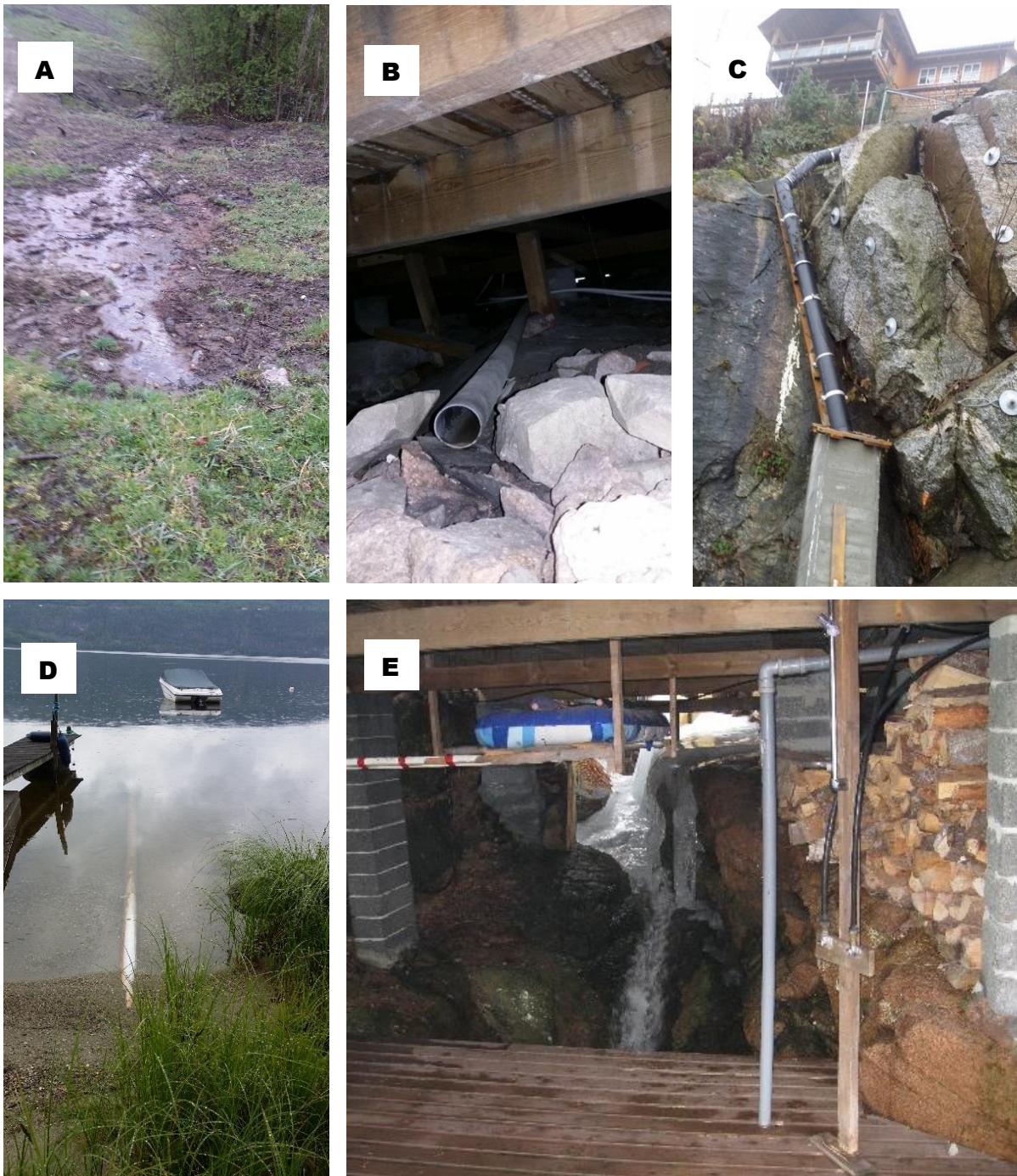
Figur 10: Eksempler på forurensende eller uklok disponering av avløpsvann. A) Slamavskiller med utslipp til terreng. Denne renser bare ca. 5-15 % fosfor og har ingen rensing av smittestoffer, mens kravet er 90 % rensing for smittestoffer og badevannskvalitet for tarmbakterier. B) Her føres gråvannet (vask, dusj osv.) fra hytta rett ut under hytta, og renner videre ut i egen hage. Vår prøvetaking viser at også gråvann inneholder store mengder smittestoffer. C) Provisorisk ledningsframføring på vanskelig tomt, mangler frostsikring. D) Utløpsledning føres til samme sted som familien bader. E) Avløpet fra hyttedusjen går rett i bekken som renner under hytta, deretter gjennom hagen til de andre hyttenaboene på feltet.
