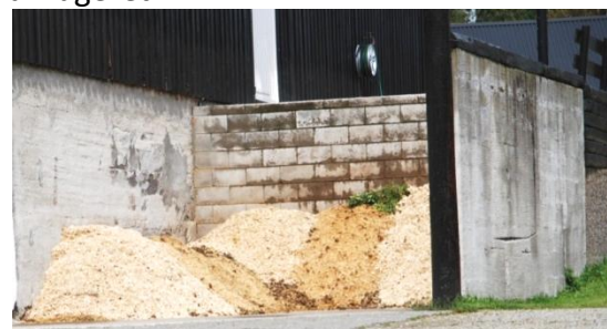
Bilde 2 Viser et gjødsellager med tett gulv og vegger.
